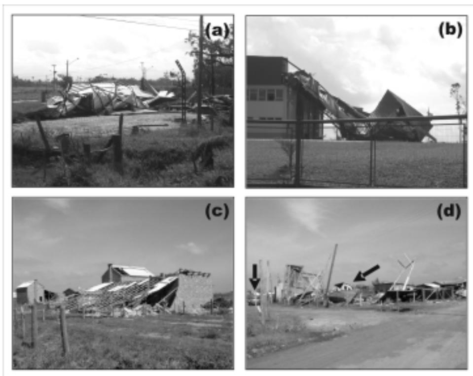
**Figura 12 – Tipos de danos causados pela força dos ventos: (a e b) destelhamentos e destruição de generalizada de telhados; e (c) casa destruída, lançada pelos ventos sobre o rio Mampituba, divisor que separa os estados do Rio Grande do Sul e Santa Catarina**
