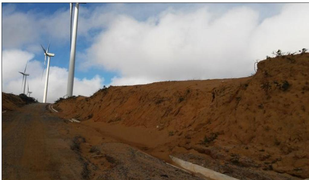
**Figura 04** - Queda de solos nos taludes da via de acesso aos aerogeradores.
