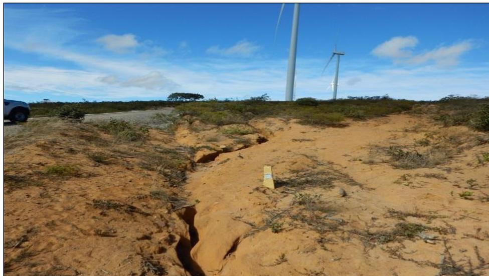
**Figura 6** - Ravina de grande extensão próxima à base de um aerogerador.
