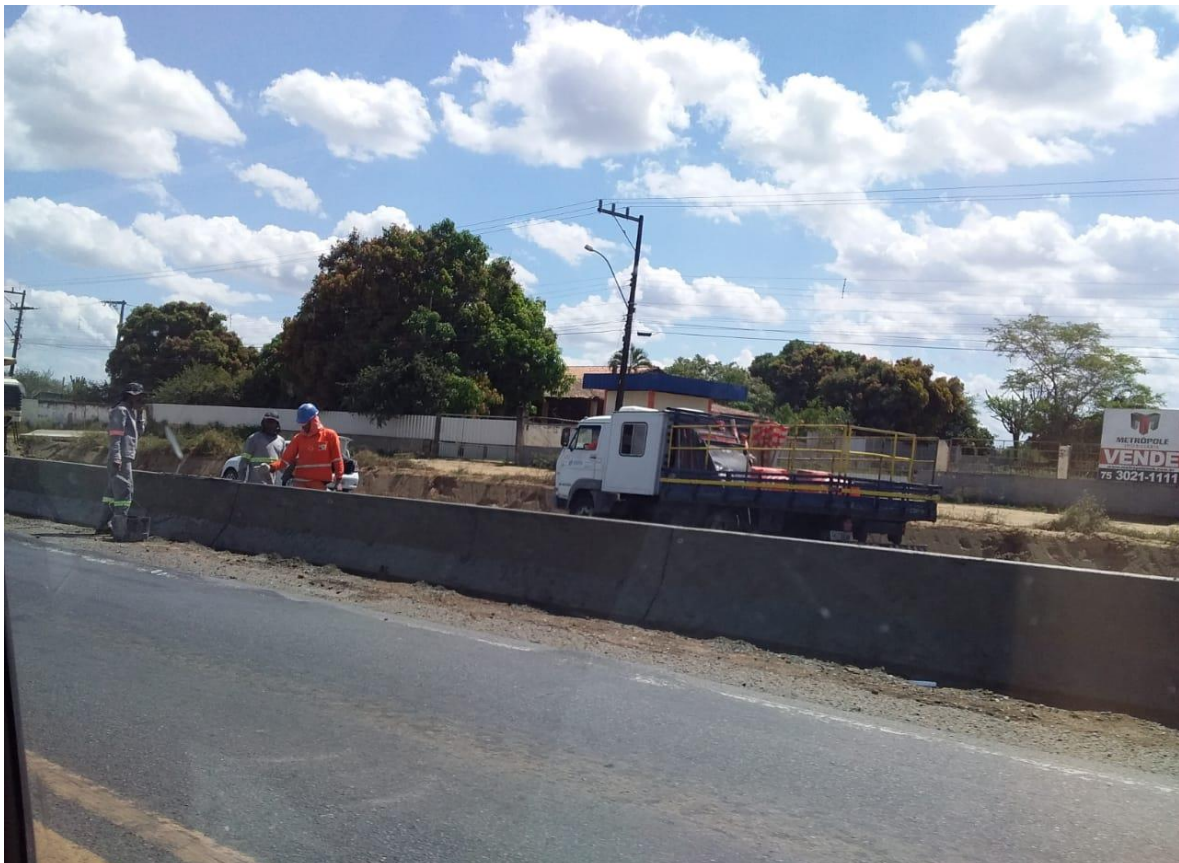
Figura 2. Duplicação da BR-116 Norte: trecho entre Feira de Santana e Santa Bárbara
