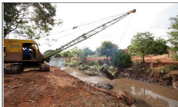
**Figura 11 - Desassoreamento do Córrego do Tanquinho**
