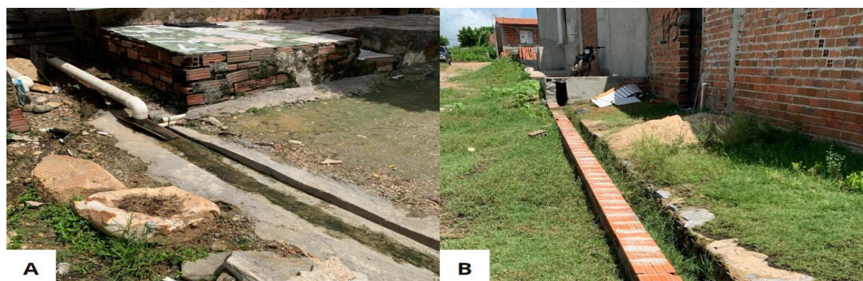
Figura 2. Canaletas improvisadas para guiar o esgoto doméstico do Assentamento. (a) Canaleta feita com Cimento; (b) Canaleta Feita com Tijolos. Fonte: Acervo pessoal (2024).
