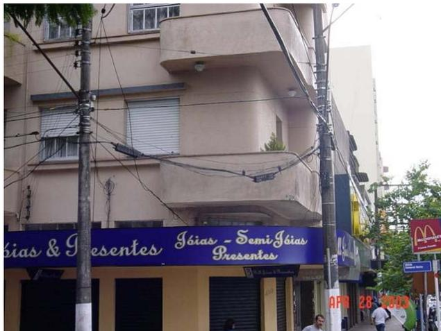
Figura 3 – Rede elétrica perigosamente próxima aos edifícios
